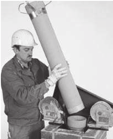
14 Schnellverschluss-Abstandhalter anbringen und versetzen der ERLUS Edelkeramik® Sanierungsrohre.
