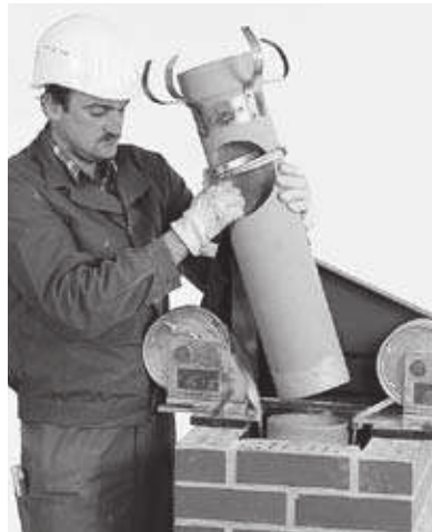
17 Bei Bedarf Edelkeramik Lochteil für Rauchrohr- oder obere Putztüröffnung einsetzen, Stutzenklemmband am Rohr fixieren.
