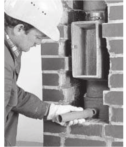
21 Ablaufrohr an die keramische Kondensat-Auffangschale stecken.
