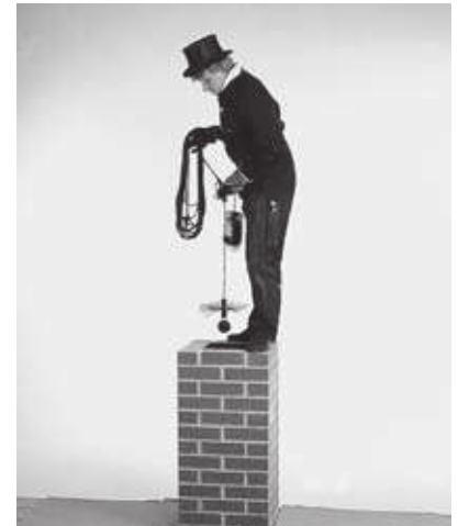
1 Reinigen des zu sanierenden Schornsteines.
