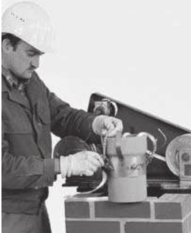
13 Ablasschelle an Kurzrohr anbringen.
