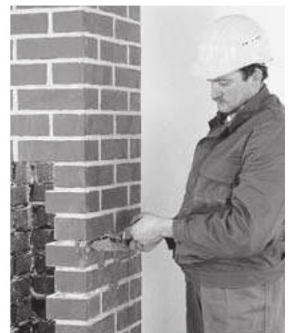
3 Schließen der Risse und nicht benötigter Öffnungen.
