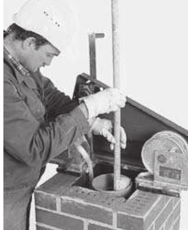
16 Überschüssigen Muffenkitt mit Schwamm aus der Rohrsäule entfernen.
