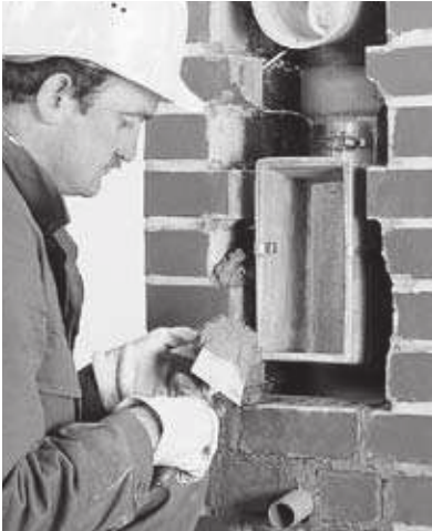
22 Anschlussdurchbrüche ausmauern und begradigen.
