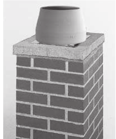
28 Fertiger Schornsteinkopf mit überstehender Abdeckplatte und keramischer Abströmhaube.
