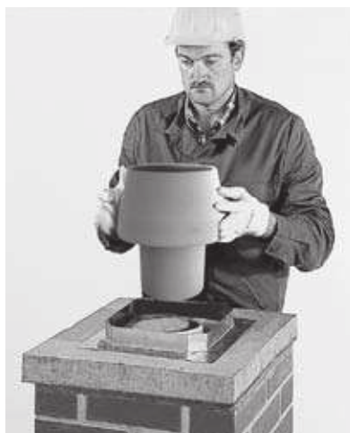
27 Versetzen des letzten ERLUS Edelkeramik® Rohres, aufdübeln der Regenschutzblende und aufsetzen der keramischen Abströmhaube mit Muffenkitt.
