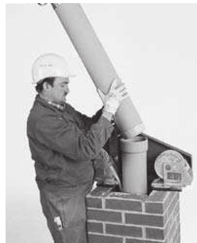
18 Weiteres Versetzen der ERLUS Edelkeramik® Sanierungsrohre.
