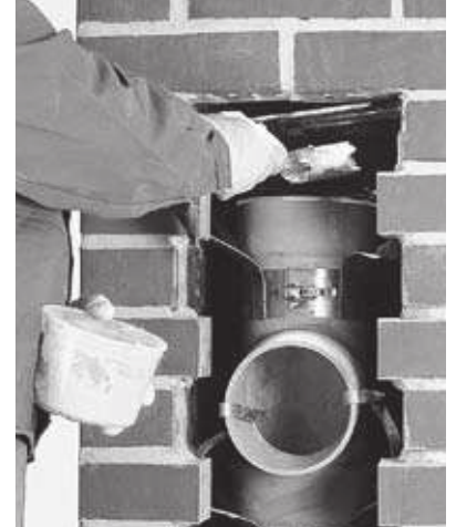
19 Bestreichen der Muffe des Rauchrohrformstückes mit Muffenkitt.
