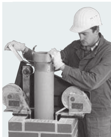
15 Ablassen der ERLUS Edelkeramik® Sanierungsrohr-Säule.
