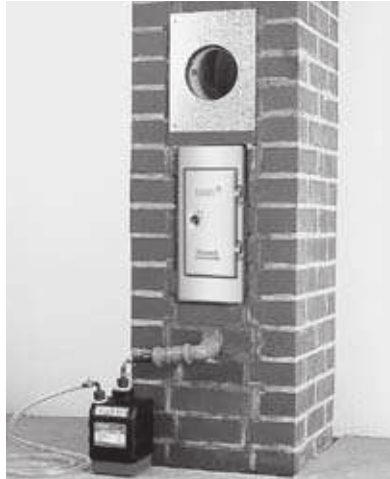
25 Rauchrohranschlussblech andübeln, gegebenenfalls Neutralisationsbox anschließen.
