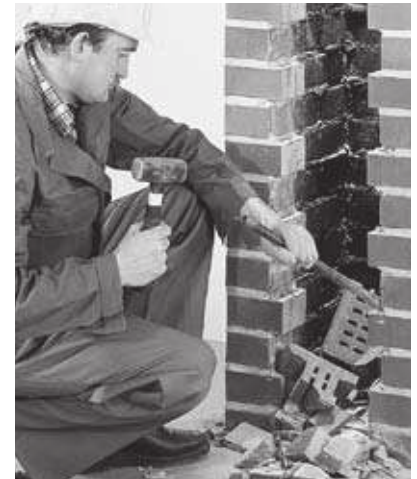
2 Ausstemmen der Anschlussöffnungen am Schornsteinschacht.
