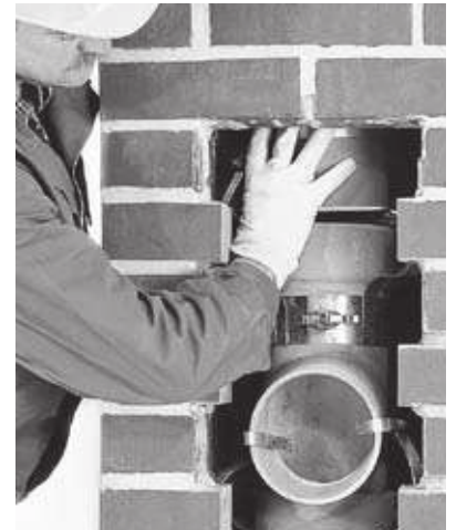
20 Ablassen der Rohrsäule in das Rauchrohrformstück.
