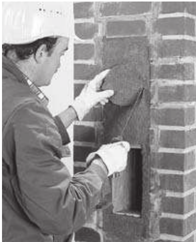
23 Ausdehnungszwischenräume mit Mineralfaserdämmplatten schließen.
