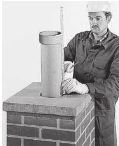
26 Setzen der Abdeckplatte, ausmessen des letzten ERLUS Edelkeramik® Rohres unter Berücksichtigung des Abstandes.
