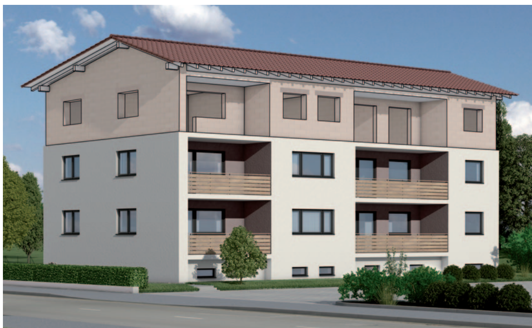
Więcej powierzchni domowej poprzez podniesienie budynku
